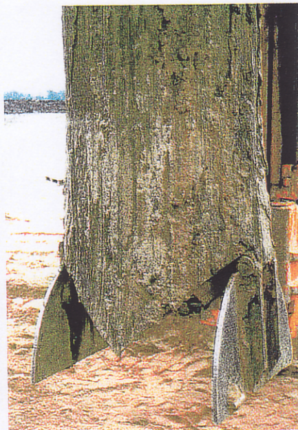
Abb. 3: Detail - Klappen beim Verdrängungsverfahren
