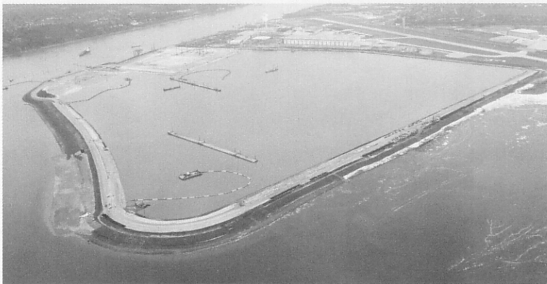
Bild 10. Hergestellter Deich mit Polderschluß und eingestauter Aufhöhungsfläche.
