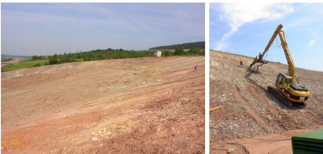
Bild 8: Sanierung a) abgeflachte Böschung b) Vernagelung
