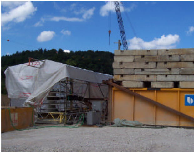
Bild 1: Überblick über die Pfahlprobepbelastung
