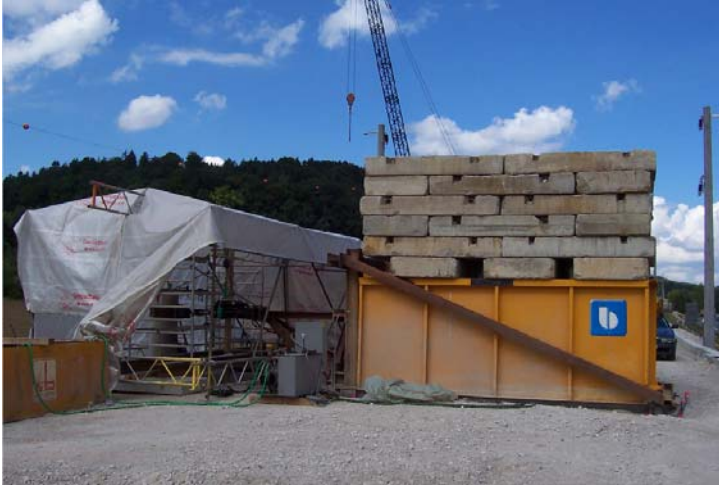
Bild 4: Überblick über die Pfahlprobelastung
