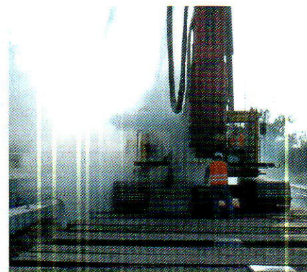
Abb. 7: Einbringen der Stahlbetonrampfpfähle; Ausrichten (links) und Rammen (rechts)
