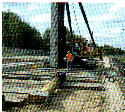
Abb. 7: Einbringen der Stahlbetonrampfpfähle; Ausrichten (links) und Rammen (rechts)
