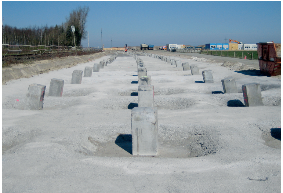
Abb. 2: Rammpfahlgründung (Strecke 1522)
