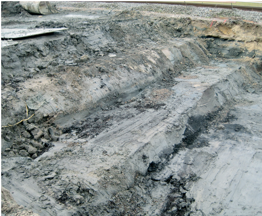
Abb. 4: Aushub für den keilförmige Betonkeil an den Übergangsbereichen von FWTG auf die freie Strecke (Strecke 1522)
