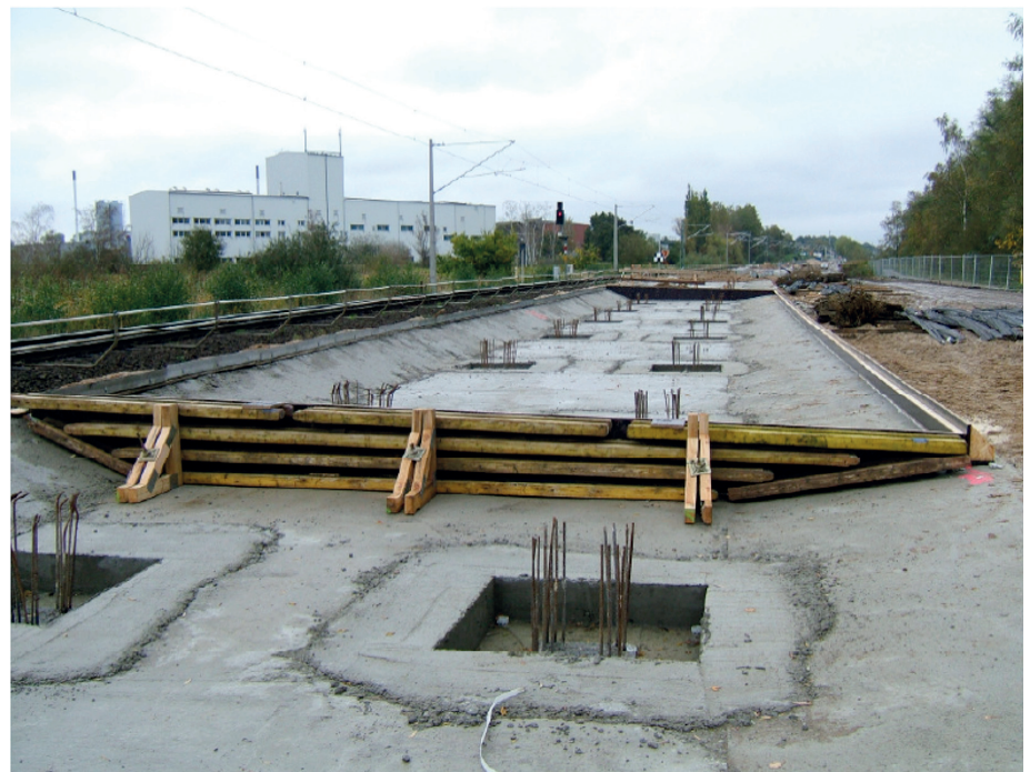
Abb. 3: Unterbeton, blockweise Abschaltung (Strecke 1113)
