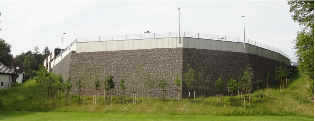
Abb. 10: Ansicht der Stützkonstruktion mit Polsterwand und Gabionenfassade
