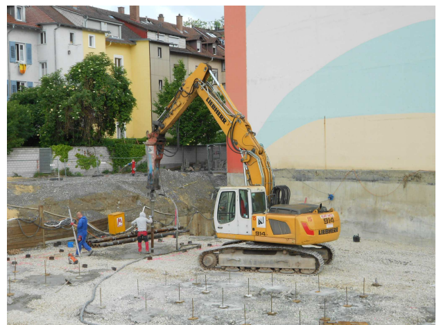
Abb. 3: Herstellung mantelverpresste Duktillrampfpfähle
