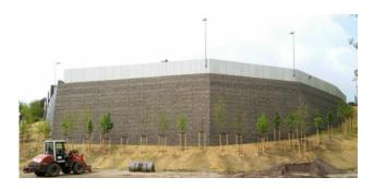
Der Neubau der Stützkonstruktion ist als Geokunststoffbewehrte Erde Konstruktion vorgesehen. Die abgewickelte Front der Stützkonstruktion beträgt in etwa 80 m und die Neigung 85°. Der Neubau wird mit einem maximalen Geländesprung von 9,0 m zwischen dem Rückbauniveau bis zum Parkplatz ausgeführt. Die Front der Stützkonstruktion wird dabei mit der sog. Um-
