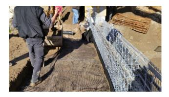
Die Stützkonstruktion wird gem. der Ausführungsplanung mit zwei Dränageleitungen unterhalb der Aufstandsfläche, sowie einer hangseitigen mineralischen Filterschicht entwässert.
