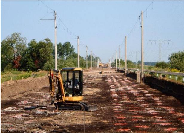
Die bisher nach der Wiederinbetriebnahme durchgeführten Verformungsmessungen zeigen nur geringe und gleichmäßige Setzungen, die in der zu erwartenden Größenordnung liegen und die geforderten Kriterien für Gebrauchstauglichkeit und Fahrkomfort der Bahnstrecke erfüllen. Die Wirksamkeit der durchgeführten Ertüchtigungsmaßnahme hat sich somit voll bestätigt.
