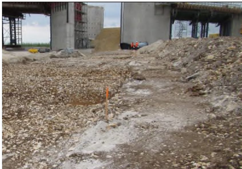
Abb. 13: Situation mit Teilverfüllung des Trogbauwerks zwischen Brücke über NBS und Brücke über BAB (Quelle: DB Projekt Stuttgart—Ulm)
