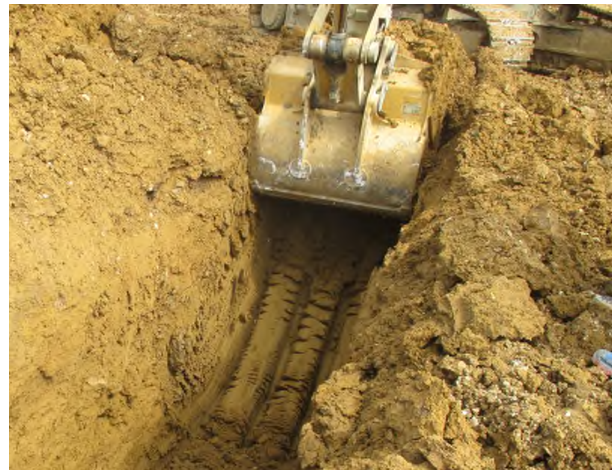
Abb. 11: Gründungsebene des Dammes D7 mit dem anstehenden Ablehm (Quelle: Kempfert + Partner Geotechnik)
