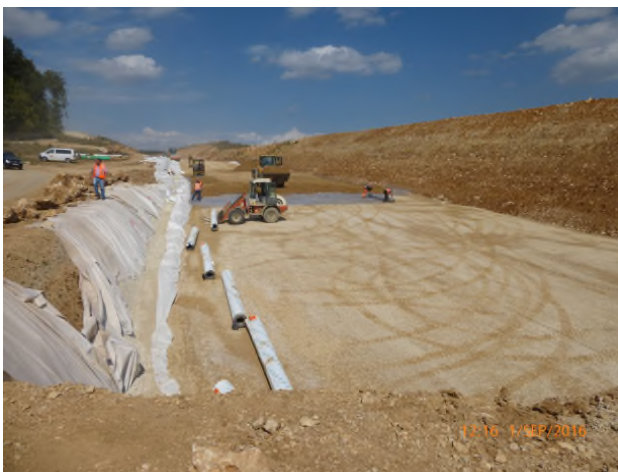
Abb. 12: Geogitterverlegung (Quelle: Kempfert + Partner Geotechnik)
