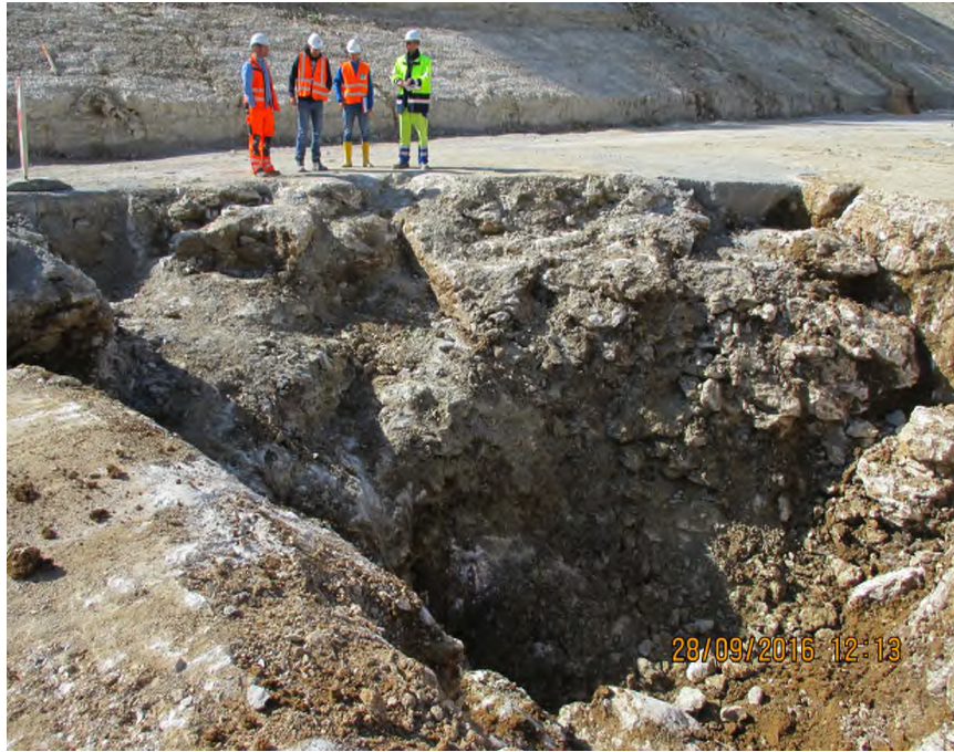
Abb. 3: Verkarstetes Relief der Weißjura-Oberfläche (Quelle: Kempfert + Partner Geotechnik)
