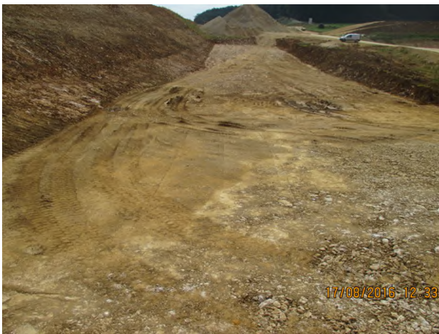
Abb. 11: Gründungsebene des Dammes D7 mit dem anstehenden Ablehm (Quelle: Kempfert + Partner Geotechnik)
