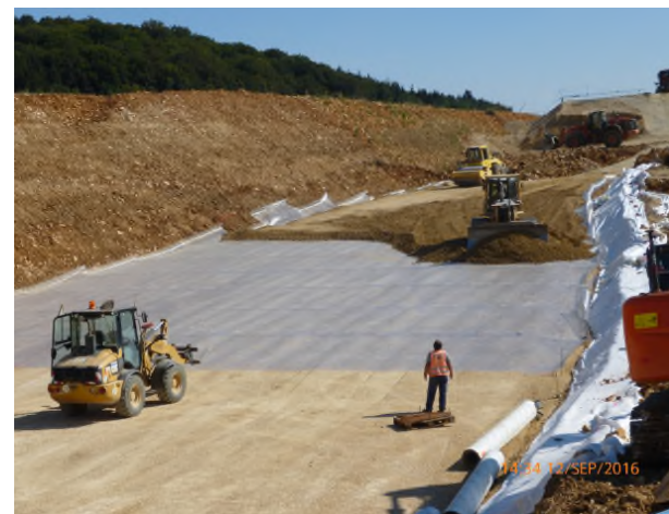
Abb. 11: Gründungsebene des Dammes D7 mit dem anstehenden Ablehm (Quelle: Kempfert + Partner Geotechnik)
